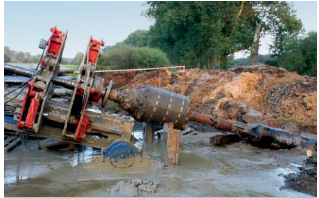
Fot. 3. Moment po zainstalowaniu rur
